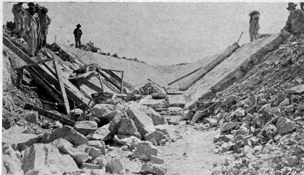
Distrito de Riego del Río Santiago, Ags.—Revestimiento de mampostería del Canal Principal a la salida del túnel de derivación, ejecutado en 1928.
