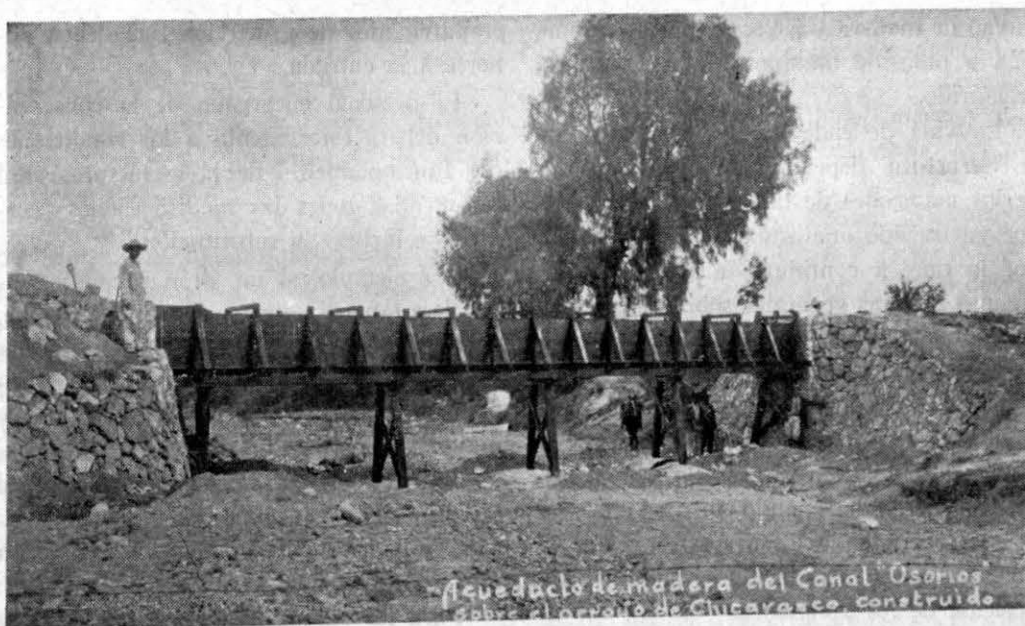
Acueducto de madera del Canal "Osorios" sobre el arroyo de Chicavasco construido por el Sistema Nacional de Riego Núm. 3.
