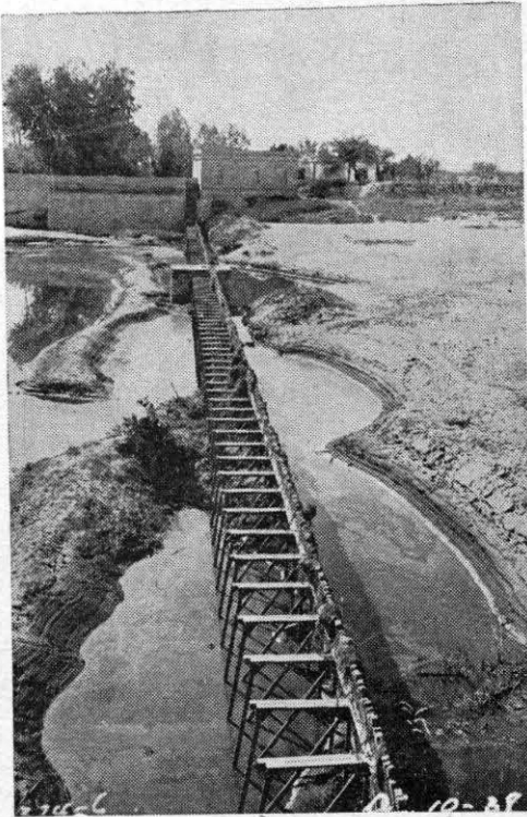
Distrito de Riego de la Región Lagunera.—Presa de Guadalupe. Vista tomada desde la ribera izquierda. Nótese el depósito de azolve.
