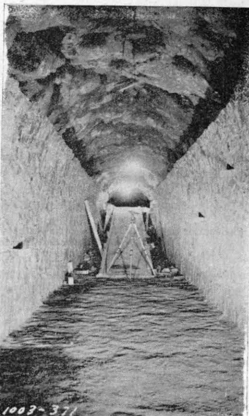
Fot. N° 2. Revestimiento de las paredes. Pueden apreciarse los tubos abogados en la mampostería, que servirán posteriormente para el inyectado.
