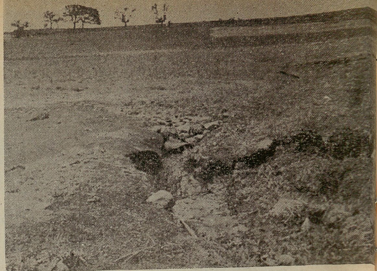
Fot. Núm. 25.—Efecto producido por la pequeña presa de piedra que aparece en la foto que estabilizó el suelo de la parte superior, aguas abajo, se ve el efecto de la erosión no estabilizada.
