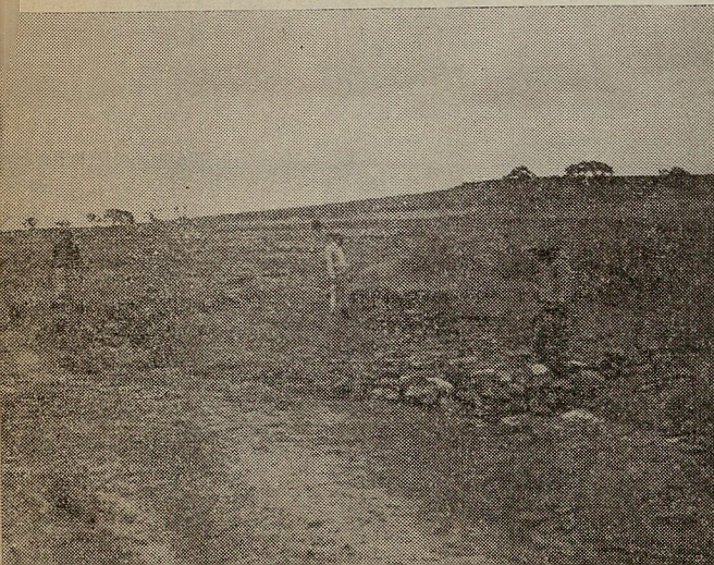
Fot. Núm. 24.—Forma como se corrige una torrentera por medio de presas de piedra que son grandemente permeables pero permiten el depósito del azolve, estabilizando pequeñas porciones de la torrentera.
