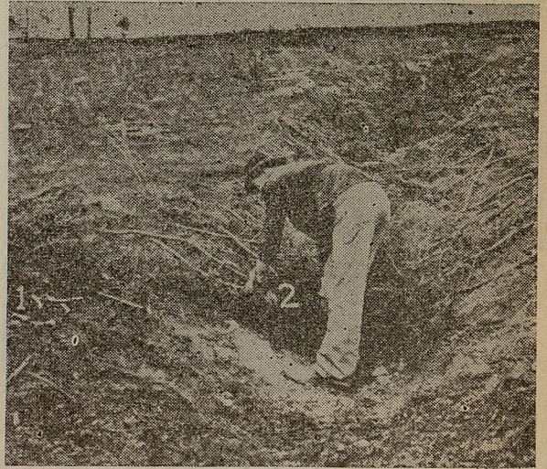
Fot. Núm. 11.—Colocación de las ramas. 1). Usense ramas verdes de cedro o pino con las puntas hacia el fondo de la torrentera, el lugar de corte no será de más de 4 cm. de diámetro. 2). Apisónense las ramas con los pies procurando abarquen todo el lecho de la zanja, formando una capa de unos 10 cm. de espesor.
