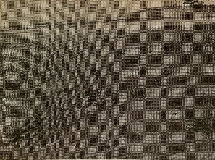
Fot. Núm. 26.—Las presitas de piedra producen efectos notables para estabilizar las torrenteras, como puede apreciarse en esta foto, las cuales son rápidamente invadidas por el pasto que las estabiliza totalmente.
