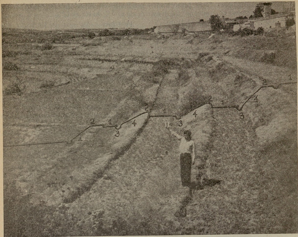
Fot. Núm. 31.—Terrazas construídas en las laderas de una loma frente a la fábrica de La Trinidad, en Tlaxcala, en terrenos de fuerte pendiente. (1) Parte cultivada de la terraza. (2) Caballete. (3) Canal de riego y de desagüe. (4) Taludes de 1 x 1.25 y 1 x 1.5 empastados para conservar la terraza.
