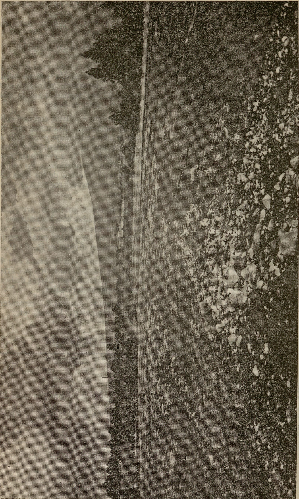
Aspecto de la Barranca de Briones, Tlax., mostrando el material acarreado antes que se construyeran las presas de contención. Actualmente el agua sólo arrastra material fino, y comienza a ahondarse el cauce.
