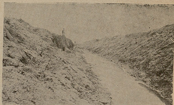
Distrito de Riego de Don Martín, Coah., y N. L. Vista del dren del Nogal en 1935.
