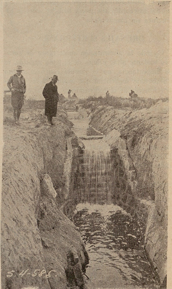
Distrito de Riego de Don Martín, Coah., y N. L. Caída construida de mampostería para permitir el paso de canal al dren.
