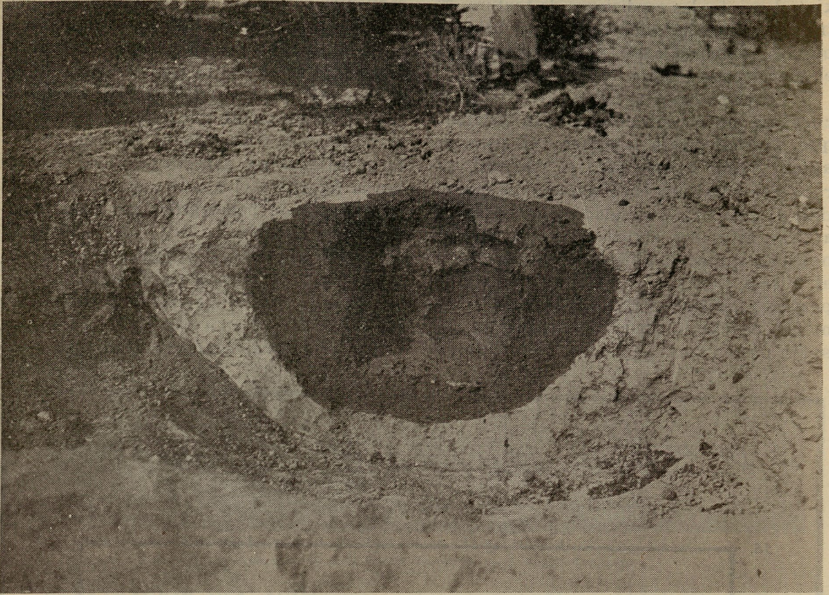
Foto N° 2.—Prueba de permeabilidad efectuada en una Arcilla Tlahualilo. Nótese la penetración mayor en el sentido horizontal que en el vertical.
