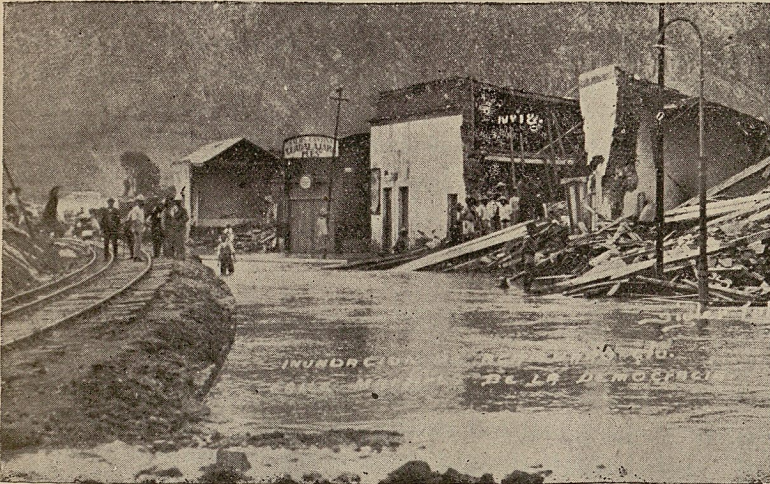
Efectos de la inundación en Acámbaro, Gto. Derrumbe de casas por reblandecimiento de cimientos.
